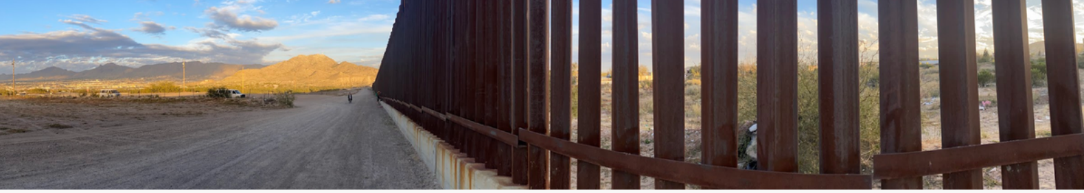
The Border Wall, El Paso, Texas.
